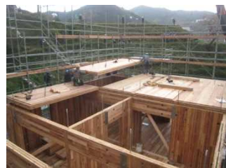
CLTを用いた施工例
