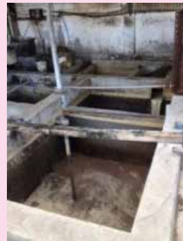
既存の排水処理槽
