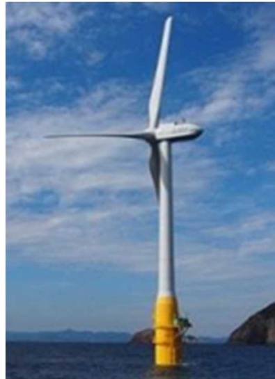
図21：長崎県五島市の浮体式洋上風力発電
