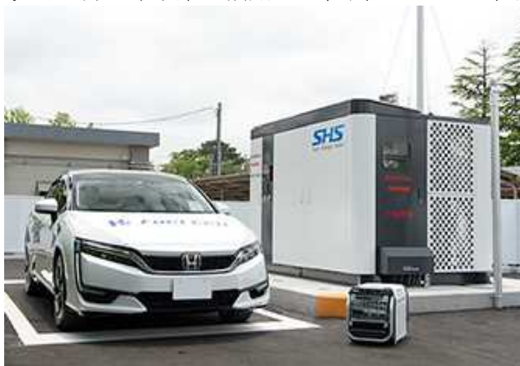
図 19：再エネ水素を活用した社会インフラの低炭素化促進事業により設置を支援した水素ステーション（福島県郡山市）
