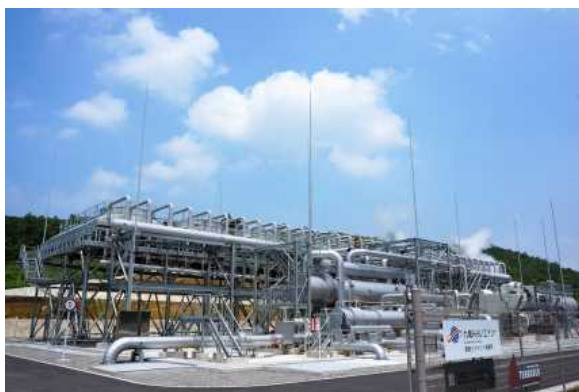
図 16：地熱発電と温泉地の共生：菅原バイナリー発電所（大分県玖珠郡九重町）
