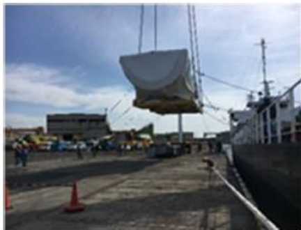
新しいガスタービン車室の水切り
