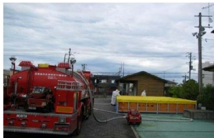
防火水槽の増設
