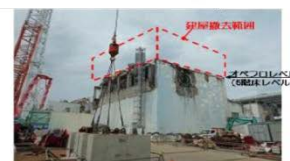
4号機上部建屋ガレキ撤去工事完了時(平成24年7月)
