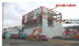
4号機ガレキ撤去工事開始時(平成23年9月)
