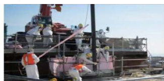
4号機使用済燃料プール内の未使用燃料の試験取出し作業の様子(平成24年7月)
