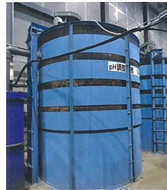
塩化第二鉄溶液と苛性ソーダを加え、細かい凝集物をつくります。
