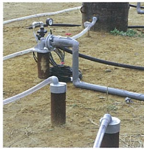
6つの揚水井戸から、1日あたり約300m 3 の地下水を汲み上げ、処理棟へと送ります。
