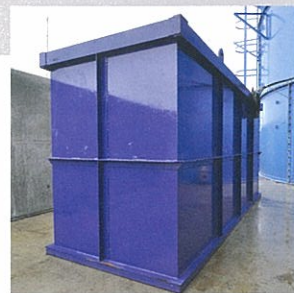
放流水のpHと濁度を連続監視し、一定の量で下水道へ放流するための設備です。(放流量:300m 3 /日)
