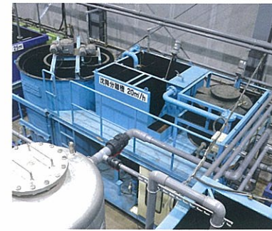
高分子凝集剤を加えることで、さらに大きな凝集物をつくり、沈殿物と上澄みとに分離します。
