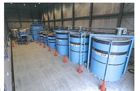
処理棟内全景
