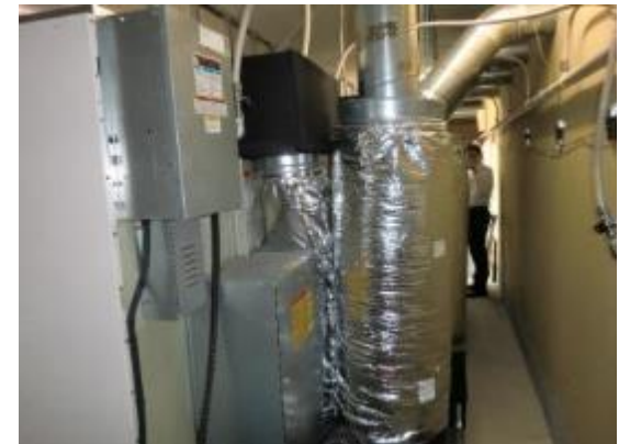
実証対象技術の設置
