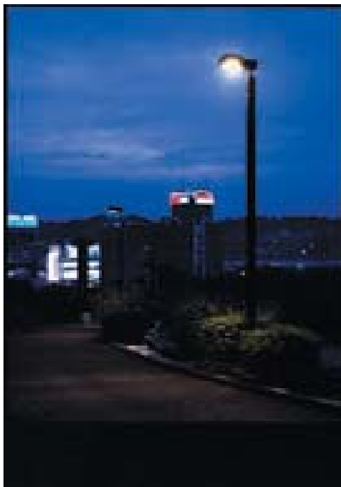
図 - 3 - 3 光漏れに配慮した道路照明の例（鹿嶋せせらぎ通り）
