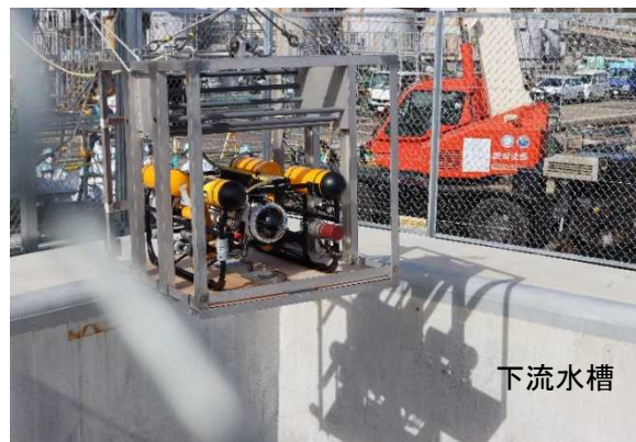
水中ROV投入状況
