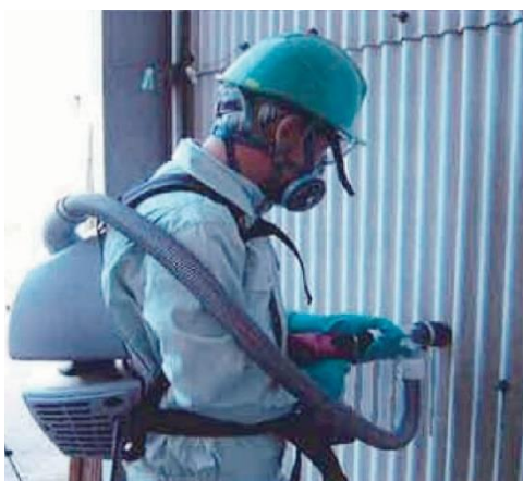
図4.11.7 機械工具による切断例
