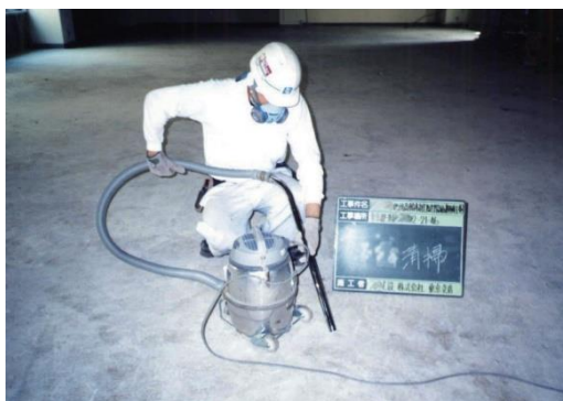
図4.11.21 清掃 高性能真空掃除機使用例
