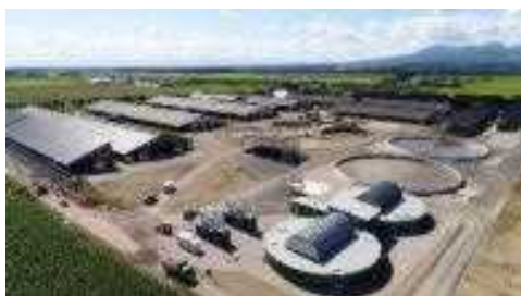
バイオガスプラント(北海道上士幌町)
