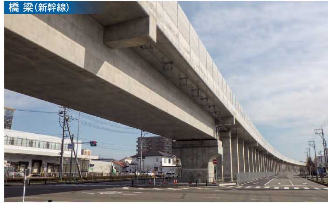
福井高柳高架橋(福井県)【北陸新幹線】
