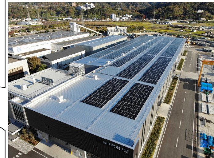
太陽光パネル
