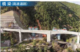
河津IC Aランプ橋(静岡県)
