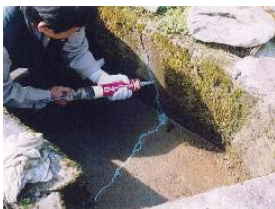
水路のひび割れ補修
