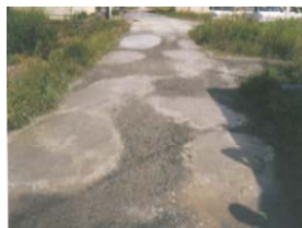
農道の窪みの補修
