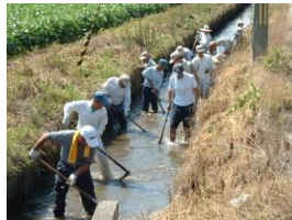
水路の泥上げ
