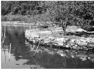
石積み護岸（昭和 50 年頃）
