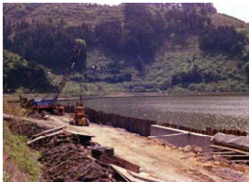
コンクリート護岸工事（昭和 50 年頃）
