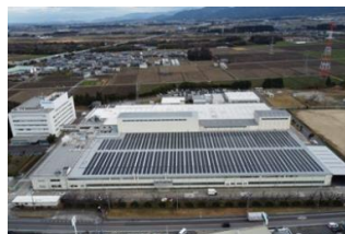
太陽光発電システム (PC LAS社 LVBD 八日市)
