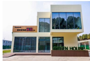
燃料電池システムを制御する グリーンハウス(中国PECW)
