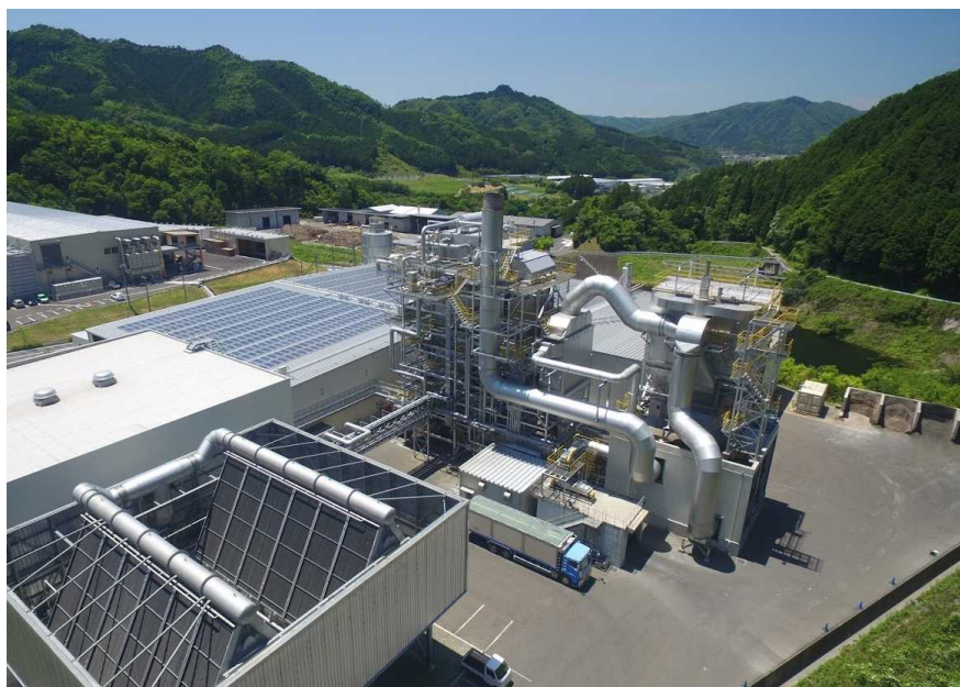
木質バイオマス発電施設の外観
