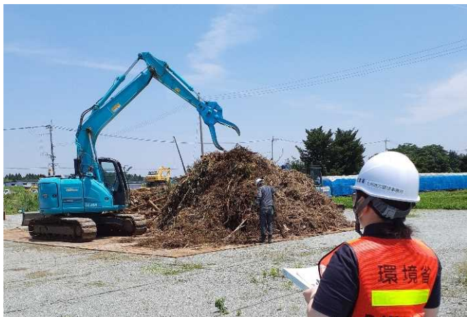
熊本県益城町の仮置場を確認する環境省職員（7/6）
