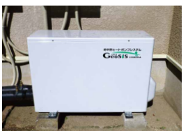
地中熱利用ヒートポンプ
