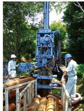
地中熱交換井の掘削状況
