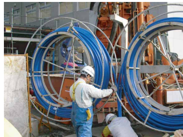
Uチューブ設置状況
