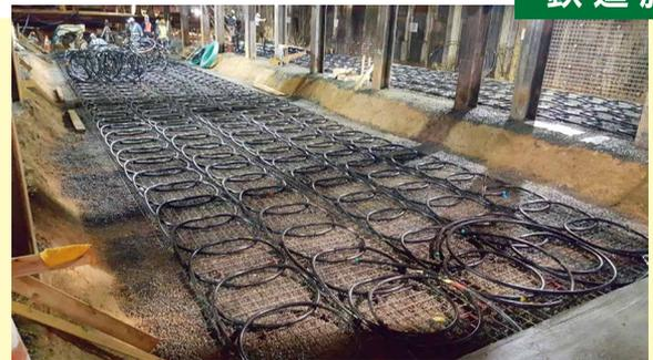
福岡市の地下鉄七隈線櫛田神社前駅では、駅の躯体下全面に水平型地中熱交換器を設置して、駅舎等の冷暖房に地中熱を導入しています。従来のシステムに比べ、約6,000kWh、CO<sub>2</sub>排出量年間約2.2t（25mプール約2個分）を削減できる見込みです。
