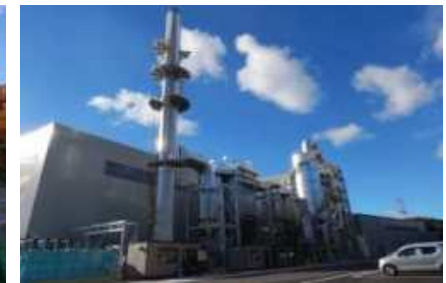
楢葉町の仮設焼却施設 出典：環境省
