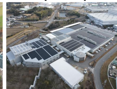
滋賀(水口)工場の 太陽光発電施設 (940kW)
