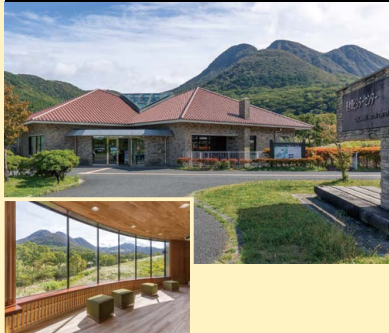
公園の魅力を伝えるためのビジターセンターの改修 (阿蘇くじゅう国立公園)
