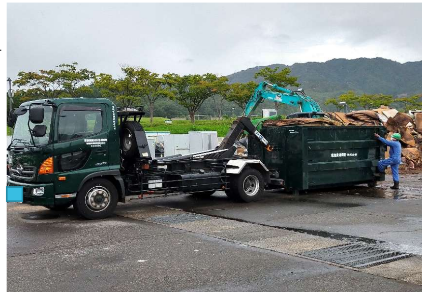
写真：仮置場からの搬出状況 出典：環境省撮影
