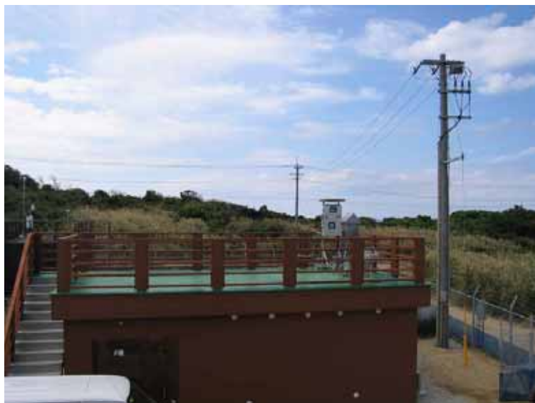
図 設置地点周辺
