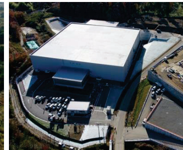
廃棄物貯蔵施設(双葉1工区)
