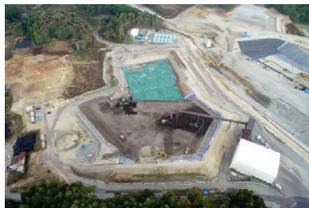
土壌貯蔵施設(双葉①工区)
