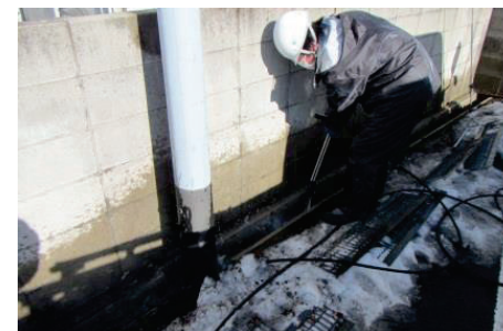
●側溝の汚泥の除去 (提供) 福島市
