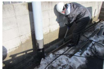
●側溝の汚泥の除去 (提供)福島市
