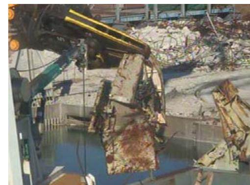
【3号機使用済燃料プールの瓦礫撤去】
