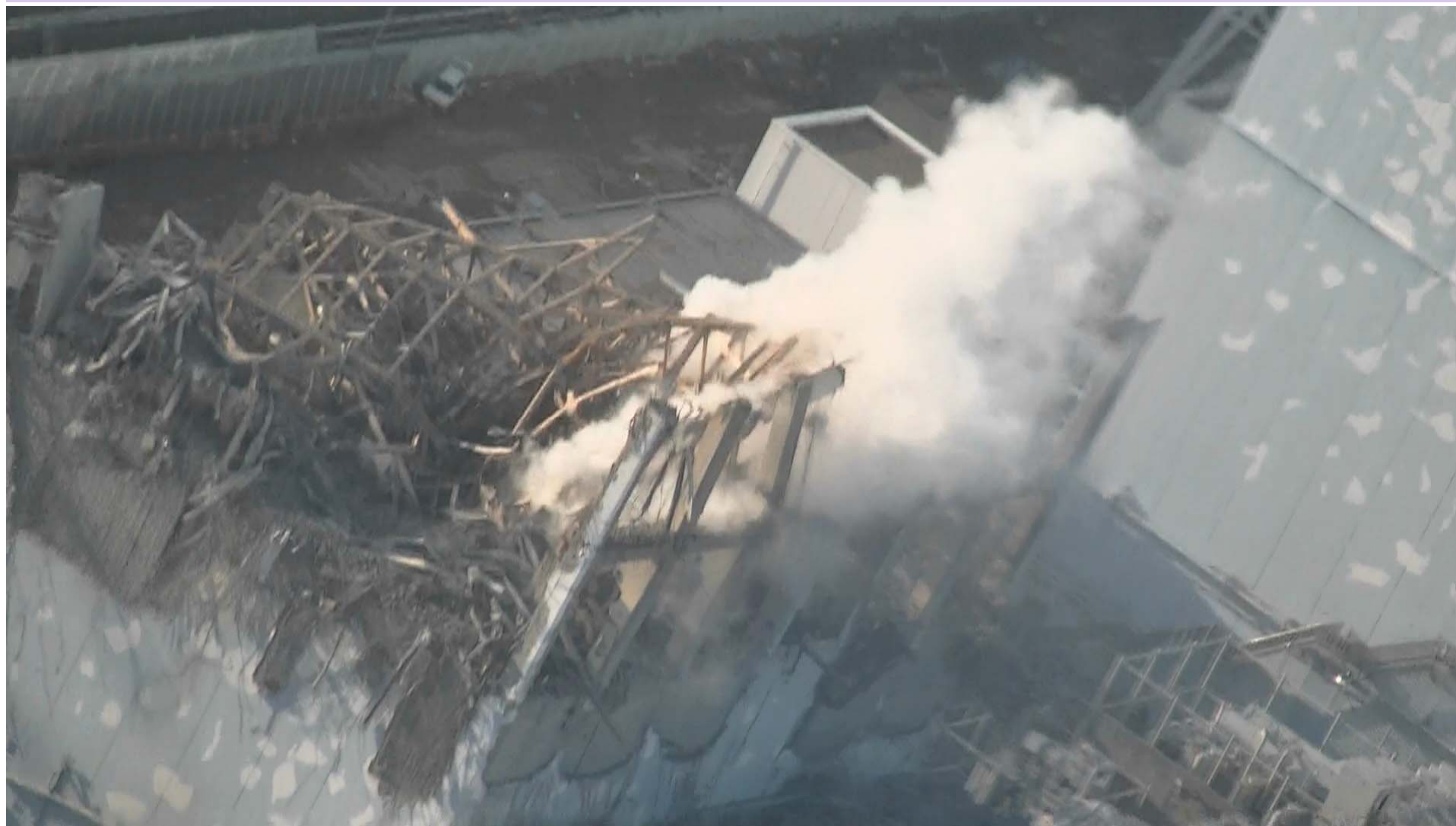
福島第一原子力発電所3、4号機（空撮） （平成23年3月16日撮影、東京電力提供）
