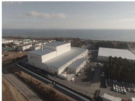
大熊町の仮設焼却施設(平成29年12月)
