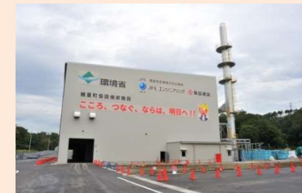
楡葉町の仮設焼却施設 (平成28年10月)
