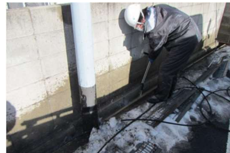
●側溝の汚泥の除去 (提供) 福島市
