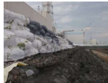
仮設防潮堤(出典：東京電力HPより)
