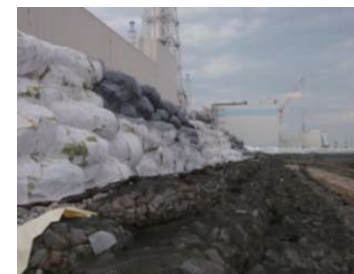
仮設防潮堤(出典：東京電力HPより)
