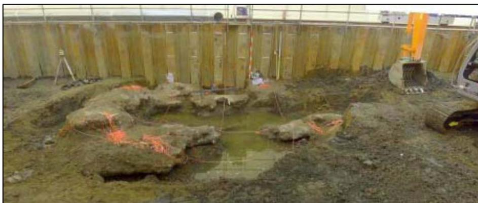
写真 1 汚染源掘削調査により発見されたコンクリート様の塊
