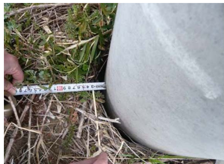
電信柱根元 隙間 3 cm
