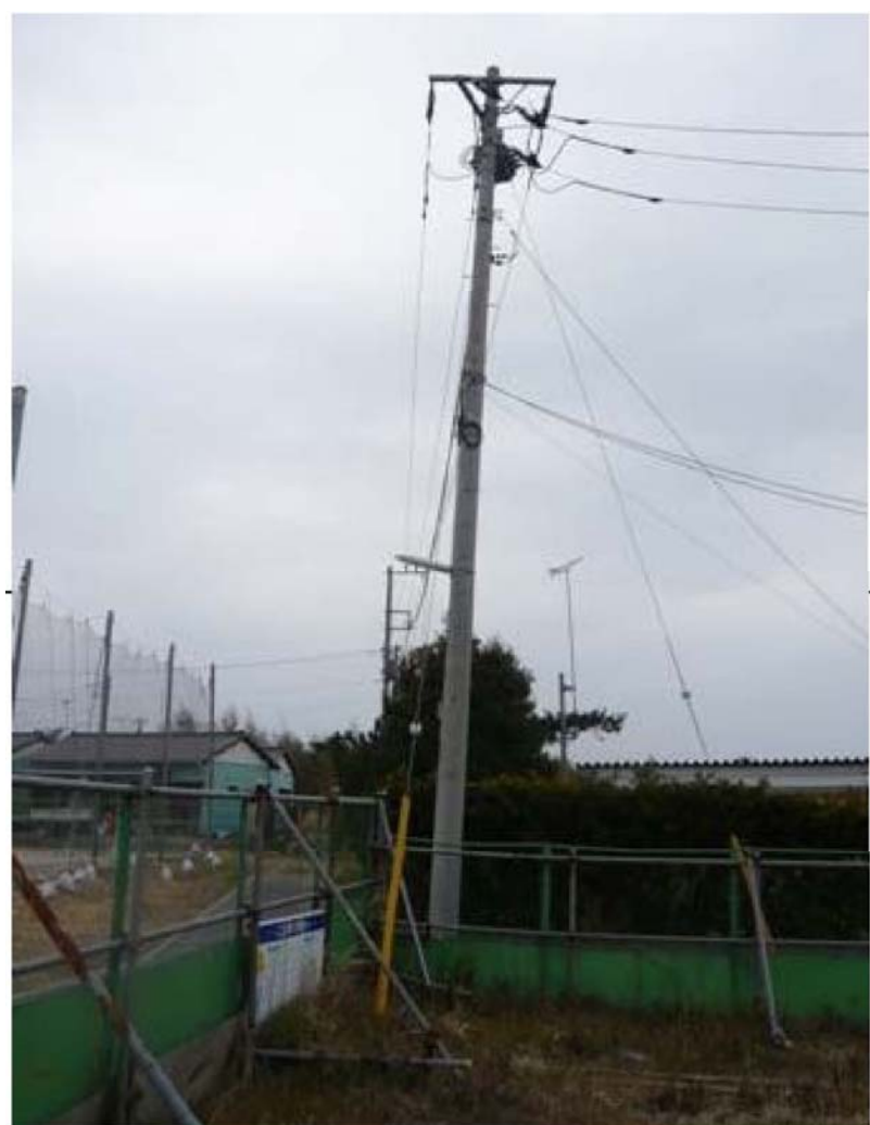
電信柱傾斜
