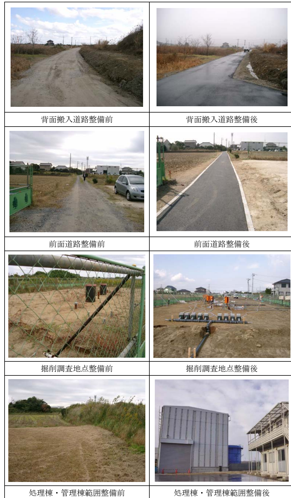
図 5.1.2 DPAA 地下水処理施設の施設整備前と整備後の状況写真
