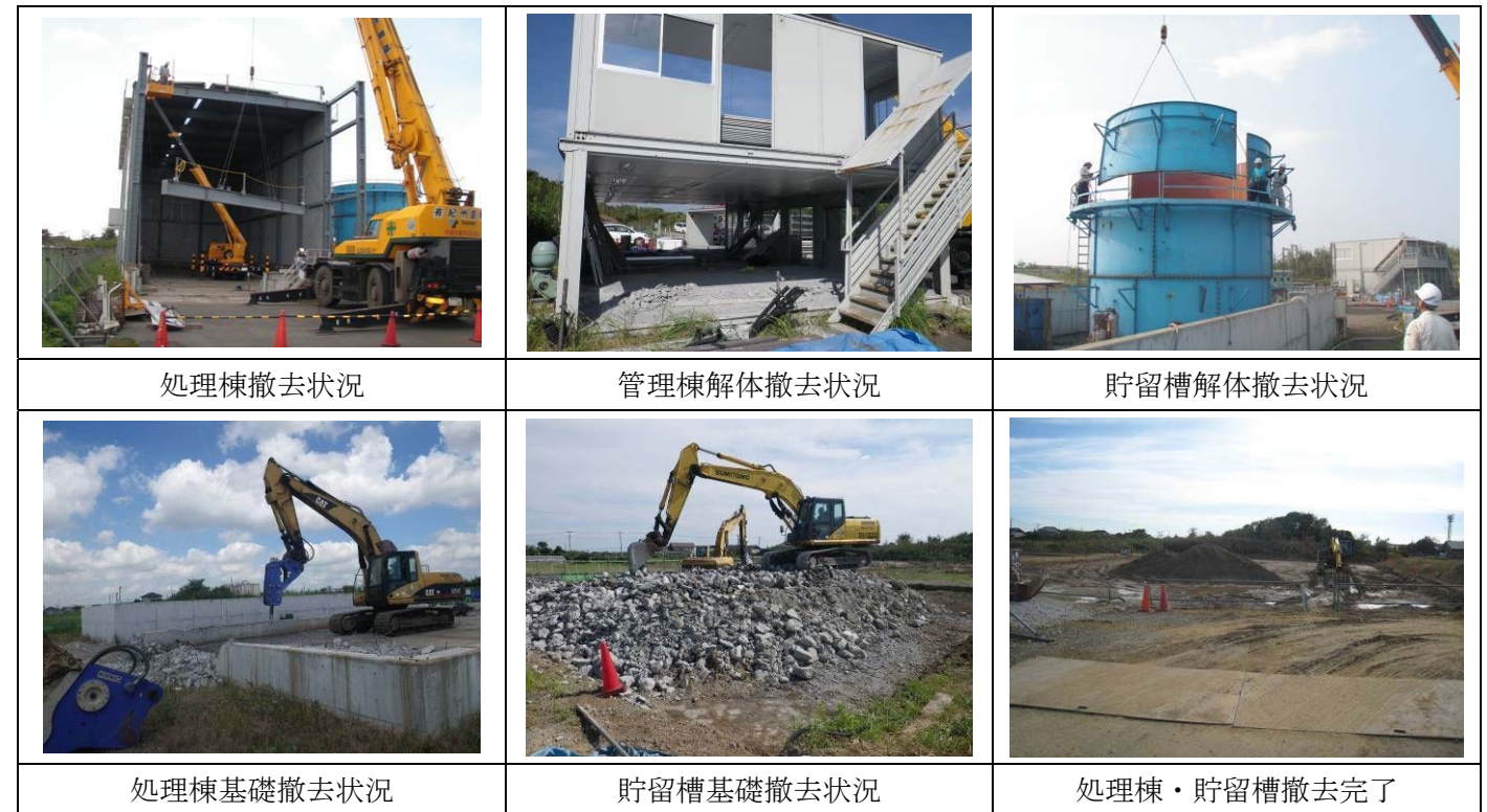
図 5.4.1 DPAA 地下水処理施設の土木・建築設備解体撤去状況
