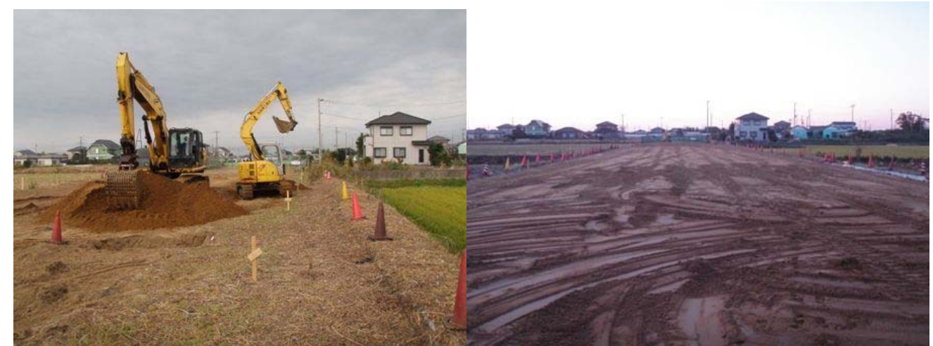
図 1.3.8 高濃度汚染対策終了後の掘削調査地点部における整地状況（左図：敷均し状況、右図：完了状況）
