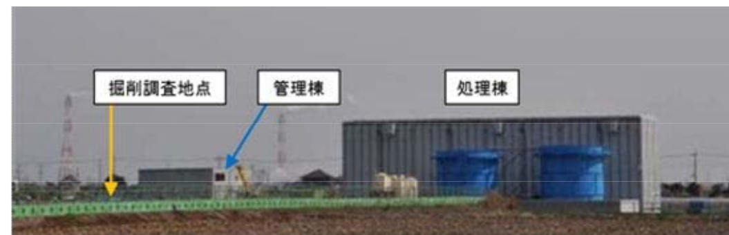
図 1.3.3 高濃度汚染対策施設の全景
