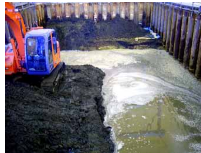
H17.4.6 塊下部を GL-4m まで掘削
