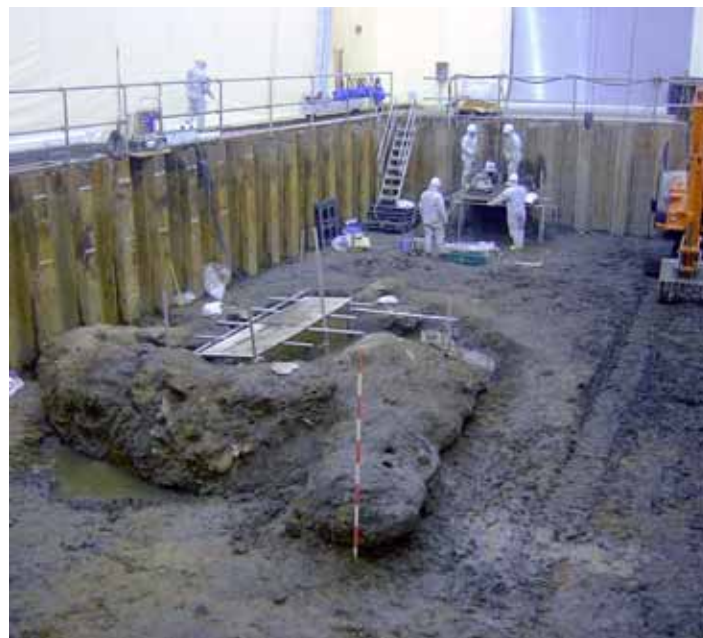
H17.2.3 西側塊のコア抜き作業 (深さ 2.5m まで掘削済み)
