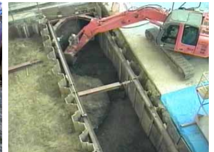
H17.7.11 西端外側部の掘削
