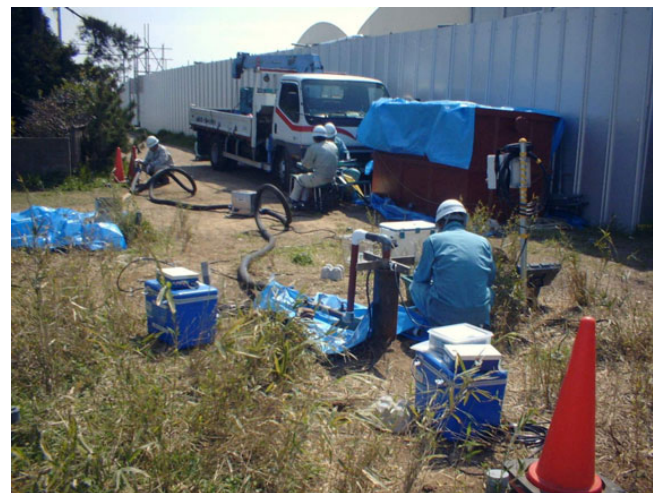
図 4.8.3 揚水試験全景
