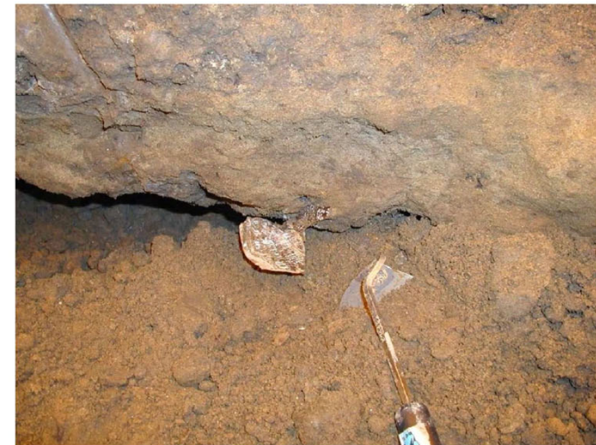
図 3.5.1.5(2) トレンチ掘削の状況 (2005年2月6日) 図版上は粘性土 (BM) 中にブロック状に存在する砂質土 図版下はコンクリート塊中に分布するコーヒーの空き缶
