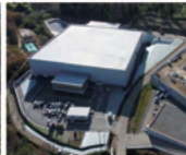
廃棄物貯蔵施設(双葉1工区)
