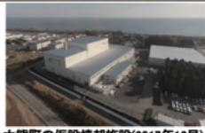
大熊町の仮設焼却施設(2017年12月)
