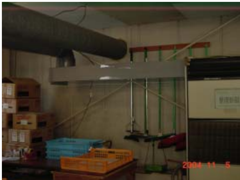
写真2 エアコンからの配管の様子
