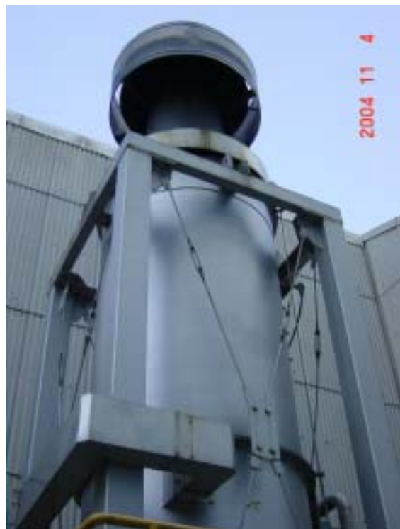
写真 1 排ガス処理装置の外観
