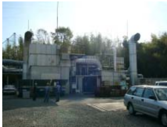
写真1 増設した蓄熱燃焼脱臭装置の様子
