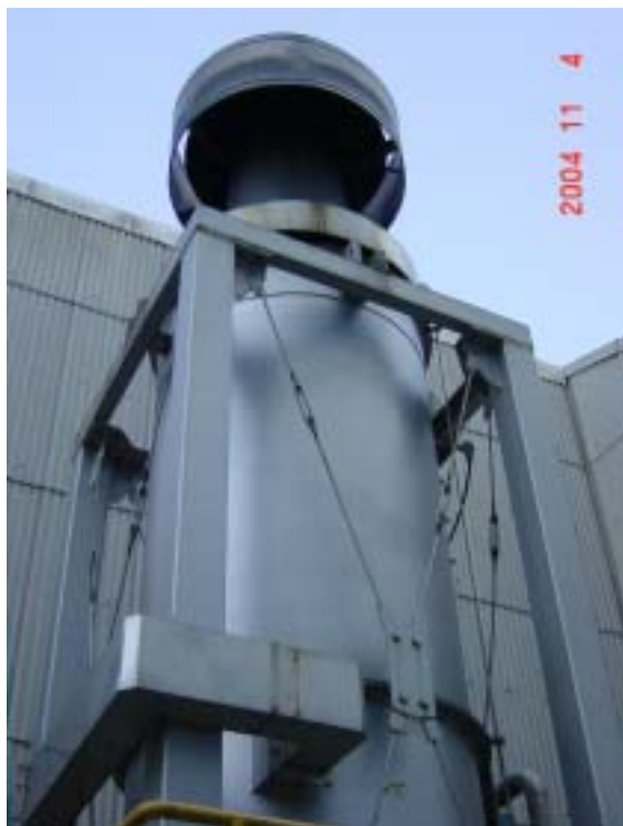
写真 1 排ガス処理装置の外観
