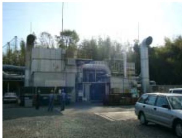
写真1 増設した蓄熱燃焼脱臭装置の様子
