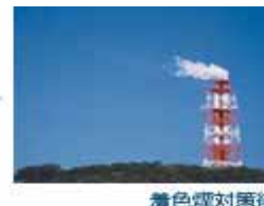
着色煙対策後
