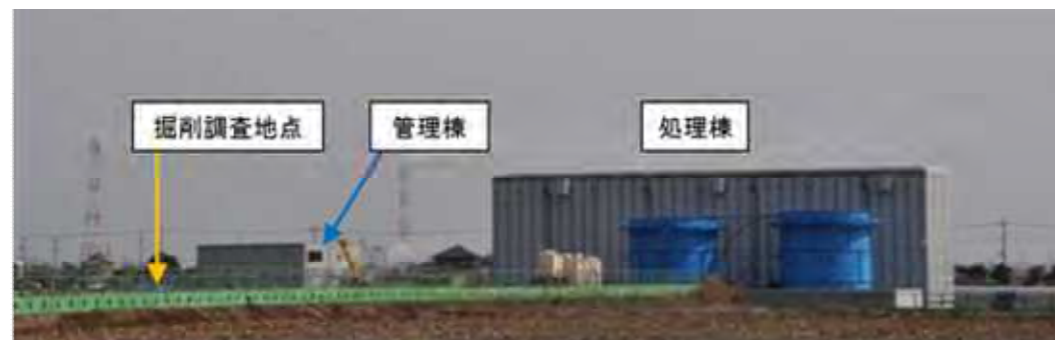
図 1.3.3 高濃度汚染対策施設の全景
