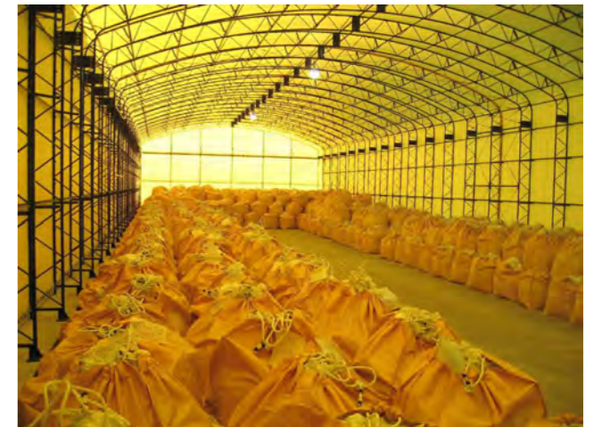
掘削土壌保管状況
