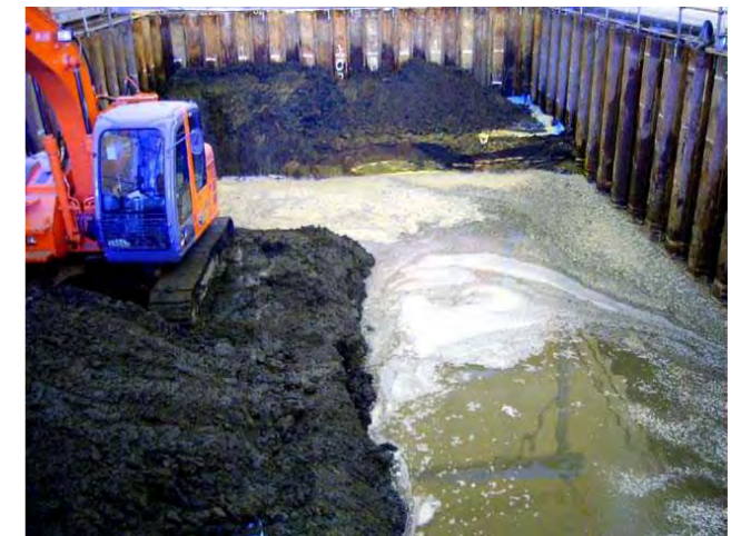
2005年4月6日(塊下部をGL-4mまで掘削)
