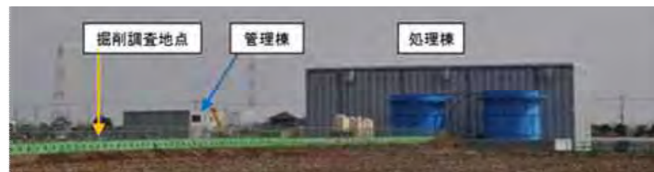
図 1.1.1 高濃度汚染対策施設全景
