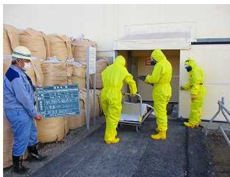
写真-1 運搬状況イメージ (試運転時: 模擬物を使用したもの)
