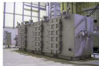
HEPA/活性炭フィルタ 排ガス処理工程の最終段に設置しており、排ガスは必ずHEPA/活性炭フィルタで浄化してから排出します。
