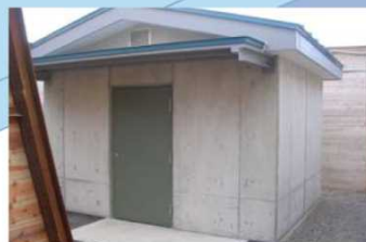
地上式三級火薬庫 無害化処理を実施するまでの間、砲弾を一時保管するための施設です。火薬類取締法の規定により周囲を土堤で囲い、様々な防犯措置が施されています。また、要員により、内部の安全確認を定期的に行います。
