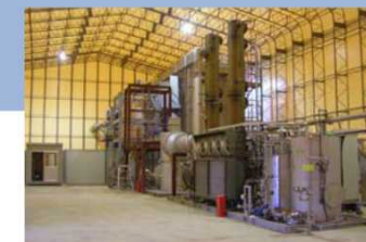
排ガス処理装置 2次燃焼炉を経た排ガスをクエンチャで急冷してダイオキシンの生成を防止するとともに、スクラバで洗浄して無機化されたヒ素・硫黄化合物・塩化水素等を除去・回収します。
