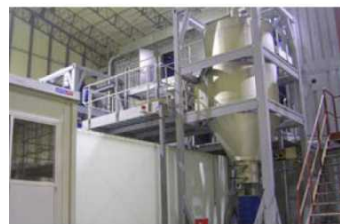
加熱燃焼炉 550°Cまで加熱可能な炉内で砲弾に充填されている火薬類、化学剤を安全に燃焼処理する装置で、旧軍の化学弾（砲弾）に対する耐震性と気密性を有しています。炉本体はDynasafe社（スウェーデン）製であり、多数の化学兵器の無害化処理実績を有しています。
