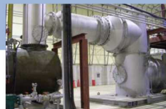
排ガス2次燃焼炉 無害化処理により発生する加熱燃焼炉からの排ガスを1200°Cで2秒以上燃焼処理します。
