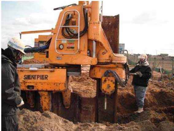
写真1 サイレントパイラーによる矢板撤去作業
