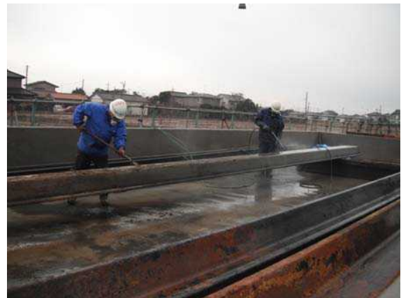
写真2 洗浄ピット内での洗浄作業
