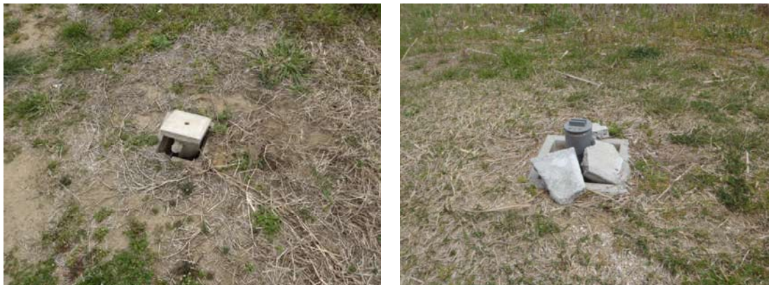
写真 A 井戸近辺におけるモニタリング井戸状況 (地震により地盤が沈下し、塩化ビニル管がコンクリート柵から出ている)
